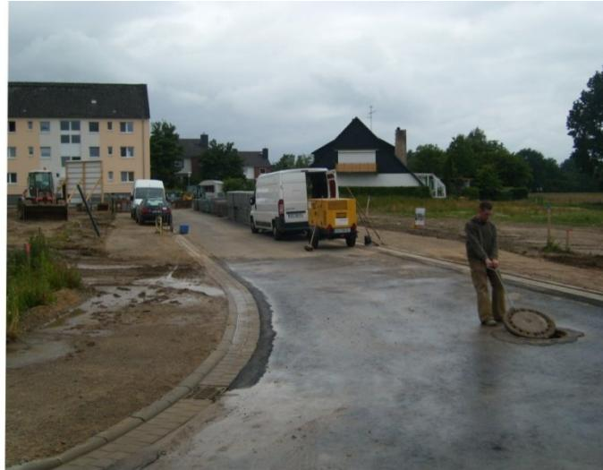
Masuch + Olbrisch hat dieses Bauvorhaben schon während der B-Planaufstellung mit der zu erwartenden Erschließungsplanung begleitet. Die Erschließungsplanung für Verkehrsanlagen, Entwässerungssysteme für RW- und SW-Kanäle, einschließlich Pumpwerke und RRB wurden von M+O komplett bearbeitet. Lph 1 bis 9, örtliche Bauüberwachung.
