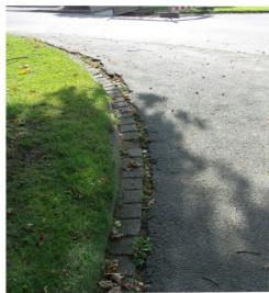
Neben einer visuellen Schadensaufnahme durch Ortsbegehung und Fotodokumentation erfolgt auch eine Aufnahme der jeweiligen Schichtdicken der Befestigung sowie Untersuchung der Frostsicherheit anhand von Bohrkernen. Auf Grundlage des festgestellten Schadensbildes wurde ein aus technischen und gesamtwirtschaftlichen Gesichtspunkten zu empfehlendes Sanierungskonzept erarbeitet.
