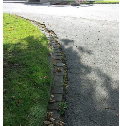
Neben einer visuellen Schadensaufnahme durch Ortsbegehung und Fotodokumentation erfolgt auch eine Aufnahme der jeweiligen Schichtdicken der Befestigung sowie Untersuchung der Frostsicherheit anhand von Bohrkernen. Auf Grundlage des festgestellten Schadensbildes wurde ein aus technischen und gesamtwirtschaftlichen Gesichtspunkten zu empfehlendes Sanierungskonzept erarbeitet.
