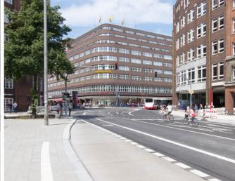
Am Gänsemarkt in Hamburg bestanden durch die damalige Haltestellengeometrie, den Missbrauch der Haltestellen zum Be- und Entladen und durch den Individualverkehr deutliche Behinderungen für den Busverkehr. Für Beschleunigung der Metrobuslinie 5 mussten diese Defizite durch eine Neuordnung der Fahrstreifen und der Nebenflächen beseitigt werden.
