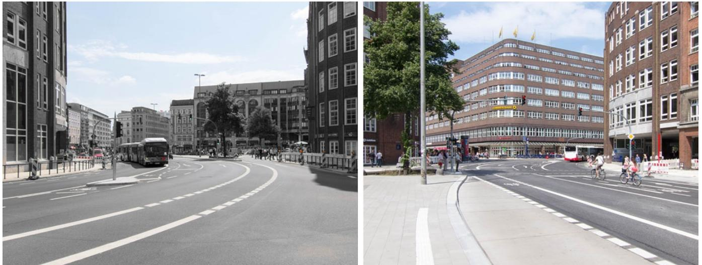
Am Gänsemarkt in Hamburg bestanden durch die damalige Haltestellengeometrie, den Missbrauch der Haltestellen zum Be- und Entladen und durch den Individualverkehr deutliche Behinderungen für den Busverkehr. Für Beschleunigung der Metrobuslinie 5 mussten diese Defizite durch eine Neuordnung der Fahrstreifen und der Nebenflächen beseitigt werden.
