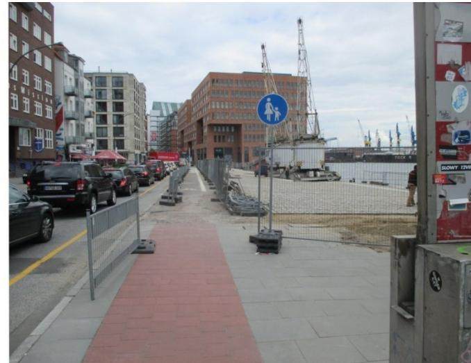
Zur Verbesserung und Sicherung der Radverkehrsführung in der Großen Elbstraße wurde diese vollständig umgestaltet und mit Radverkehrsanlagen in den Nebenflächen versehen. Die Führung in den Nebenflächen ist u. A. nötig, da die Fahrbahn entsprechend dem historischen Vorbild gepflastert wurde.
