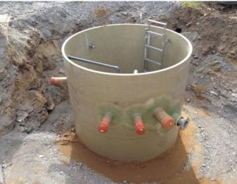
Außerbetriebnahme eines vorhandenen Schmutzwasserpumpwerkes mit nass aufgestellten Schneideradpumpen und Neubau eines trocken aufgestellten Schmutzwasserpumpwerkes mit Sperrstoffsammelraum, Förderleistung ca. 10 l/s. Neubau einer 2.500 m langen Abwasserdruckrohrleitung 125 x 11,4 mm aus PEHD einschl. 2 Stück Be- und Entlüftungsventilen in Hochpunkten und eines Entleerungsschachtes im Tiefpunkt. Kreuzung der BAB A44 mit ungesteuertem Rohrvortrieb mit Schneckenförderung DN300, Länge ca. 60 m.
